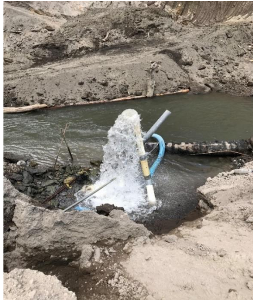
Gambar 4.6 Proses Dewatering di Sungai (sumber: Dokumentasi Pribadi)
