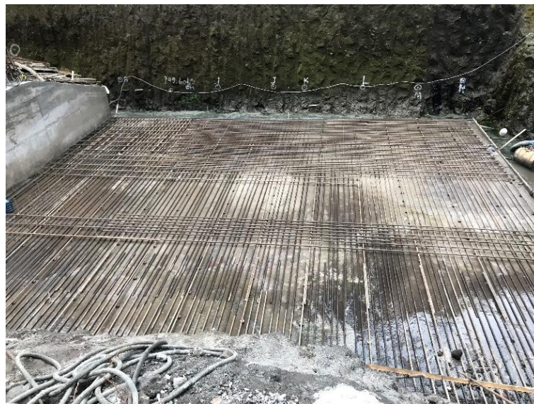
Gambar 4.17 Tulangan Utama Bawah dan Beton Decking (sumber: Dokumentasi Pribadi)
