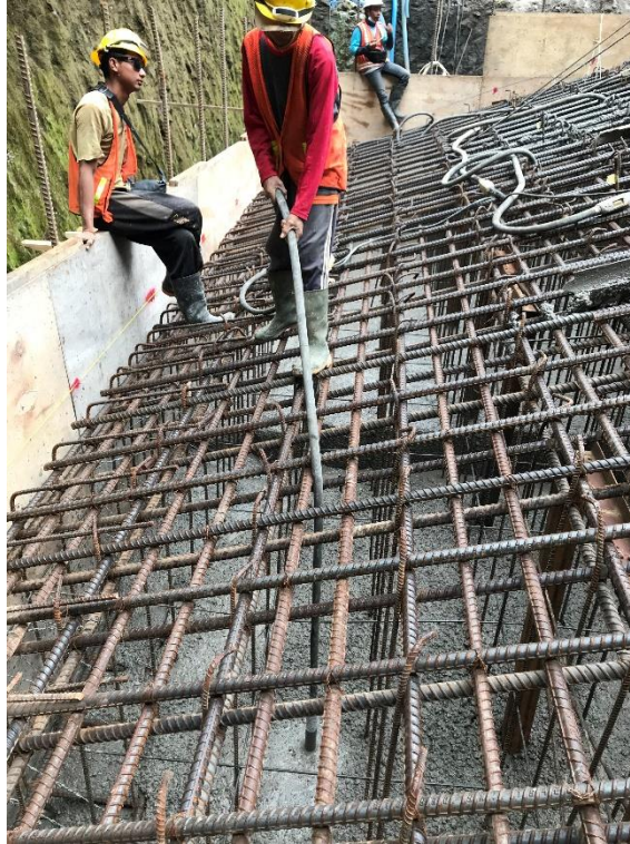
Gambar 4.15 Proses Vibrasi Beton Segar (sumber: Dokumentasi Pribadi)
