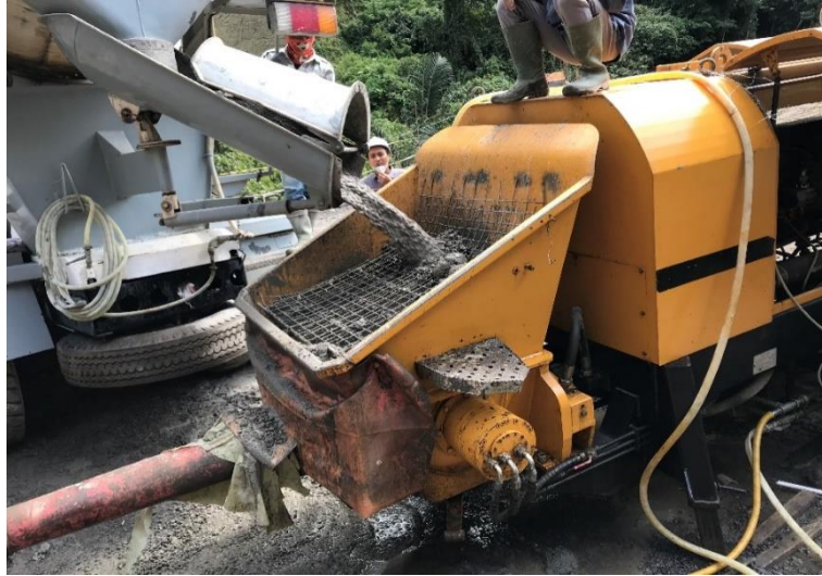
Gambar 4.13 Penggunaan Concrete Pump dalam Pengecoran (sumber: Dokumentasi Pribadi)
