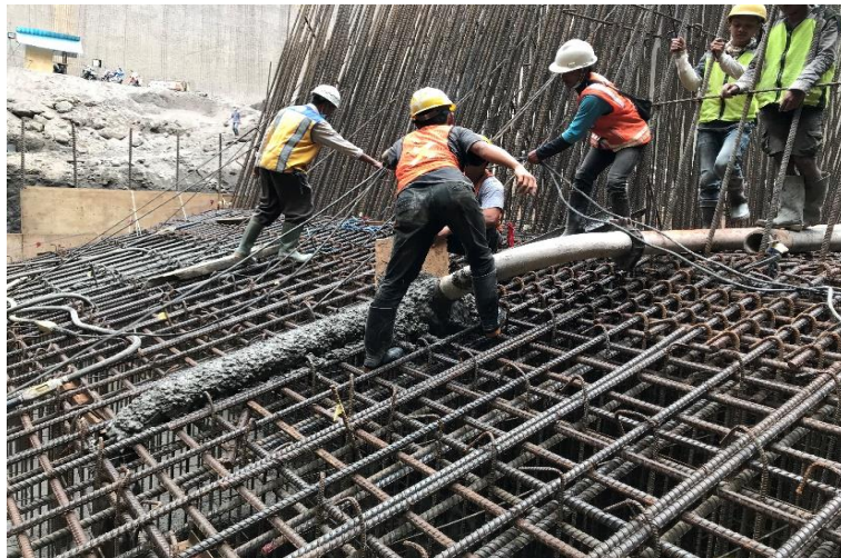
Gambar 4.14 Penggunaan Talang dalam Proses Pengecoran (sumber: Dokumentasi Pribadi)
