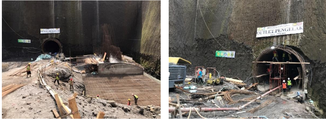
Gambar 2.16 Kondisi Lapangan Kerja (sumber: Dokumentasi Pribadi)
