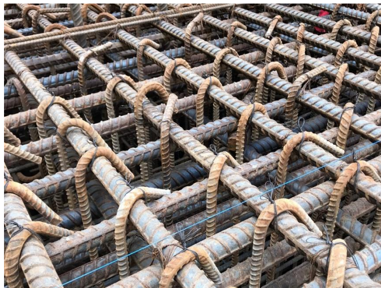
Gambar 4.9 Tulangan Bagi yang Dibengkokkan 45° (sumber: Dokumentasi Pribadi)
