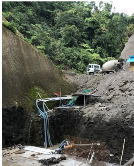
Gambar 4.5 Proses Dewatering (sumber: Dokumentasi Pribadi)
