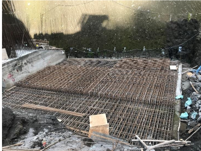
Gambar 4.18 Tulangan Utama Bawah Memanjang dan Melintang (sumber: Dokumentasi Pribadi)
