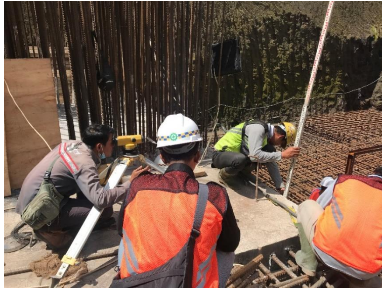
Gambar 4.16 Leveling menggunakan waterpass (sumber: Dokumentasi Pribadi)
