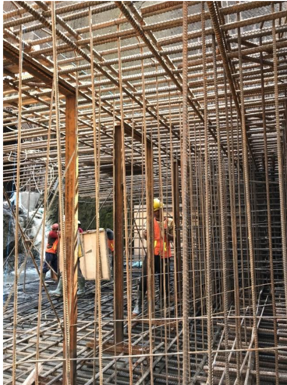
Gambar 4.8 Tulangan Bagi (sumber: Dokumentasi Pribadi)
