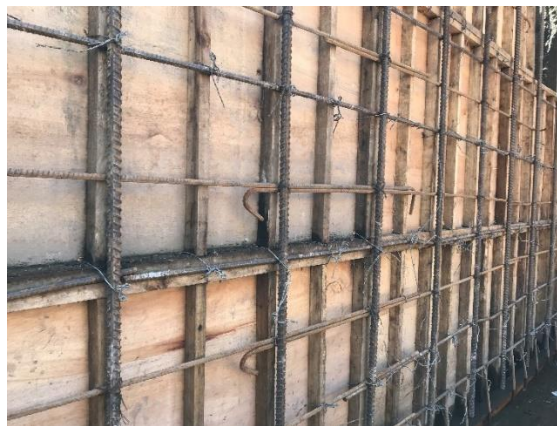
Gambar 4.11 Besi Ulir di Belakang Bekisting (sumber: Dokumentasi Pribadi)
