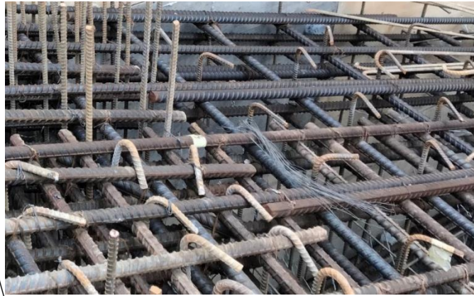
Gambar 4.10 Overlap pada Tulangan Utama (sumber: Dokumentasi Pribadi)
