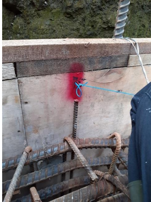
Gambar 4.12 Tanda Top Cor (sumber: Dokumentasi Pribadi)
