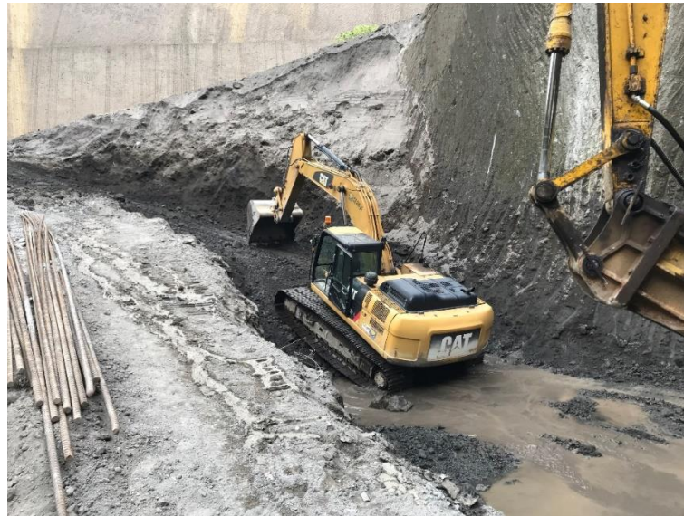
Gambar 4.20 Excavator di Site Galian (sumber: Dokumentasi Pribadi)
