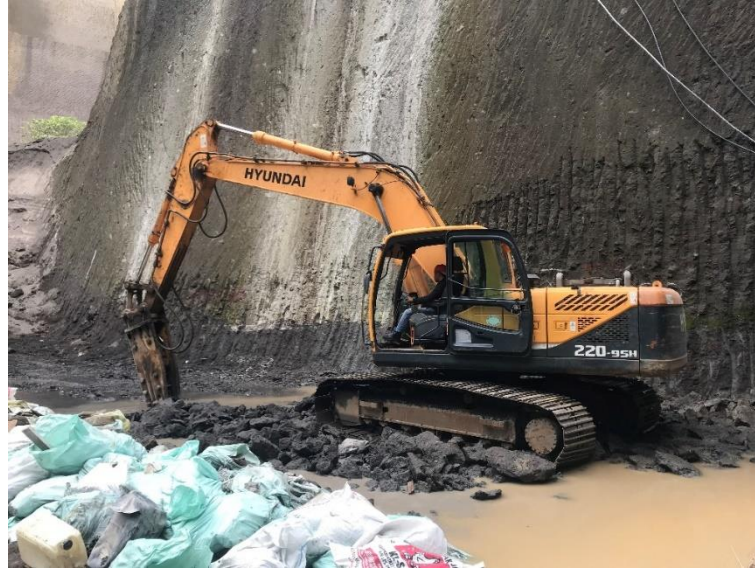
Gambar 4.21 Excavator Breaker di Site Galian (sumber: Dokumentasi Pribadi)
