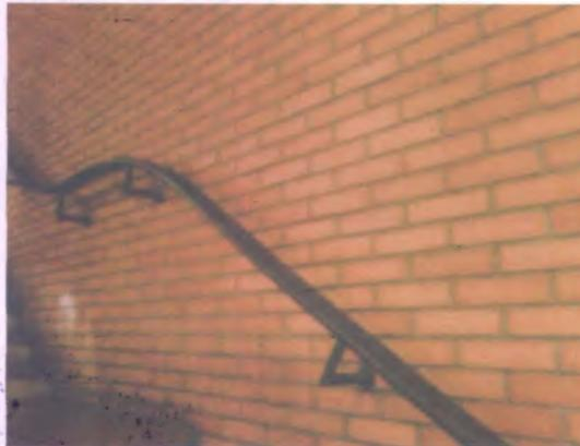
Gambar 4.16 dinding dengan batu bata ekspose sebagai finishing
