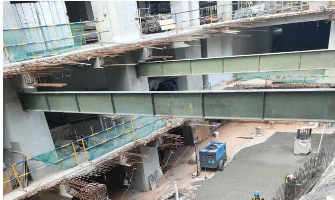
Gambar 3.2 Baja Profil sebagai Strutting.
