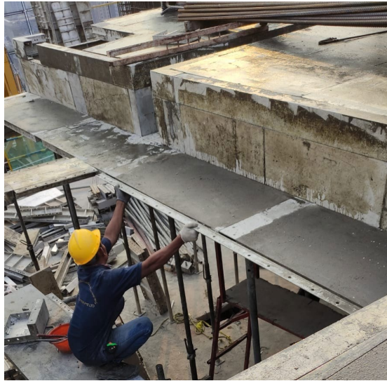
Gambar 3.20 Pemasangan Bekisting
