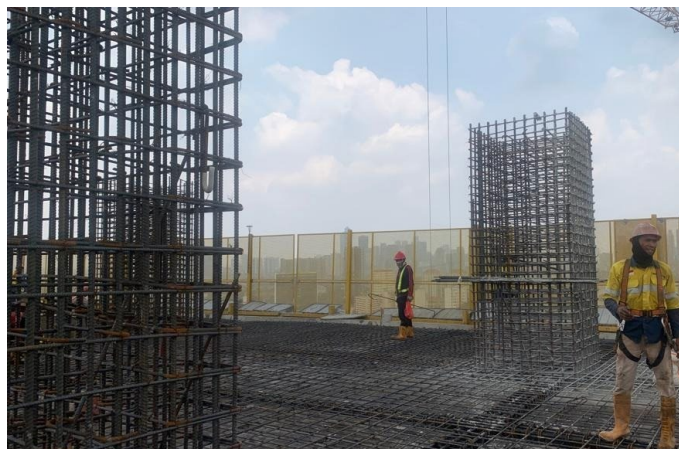
Gambar 3.18 Penulangan Kolom
