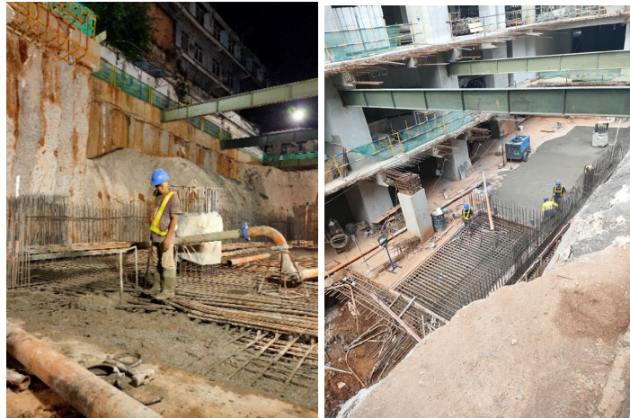
Gambar 5.27 Pengecoran Mass Concrete Raft Foundation menggunakan Pump
