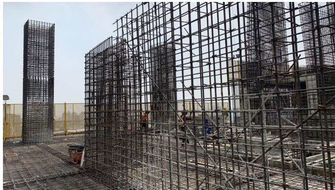
Gambar 3.23 Penulangan Shear Wall dan Core Wall
