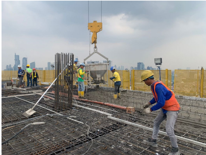
Gambar 3.22 Proses Pengecoran
