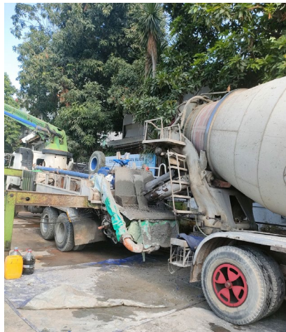
Gambar 5.26 Pemompahan Beton dengan Concrete Pump Truck
