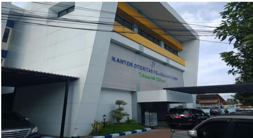
Gambar: Gedung Kantor Otoritas Pelabuhan Utama Tanjung Perak – Surabaya
