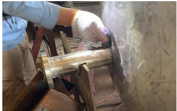
Observasi Penetrant Test pada sambungan Nozzle
