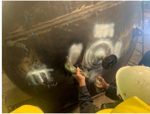
Gambar 4.11 Proses Magnetic Test ( Sumber : Dokumentasi Pribadi )
