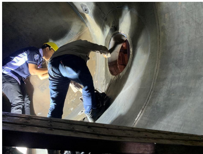
Gambar 4. 12 Proses Ultrasonic Test ( Sumber : Dokumentasi Pribadi )
