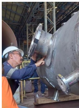
Gambar 4. 10 Proses Visual Examination ( Sumber : Dokumentasi Pribadi)
