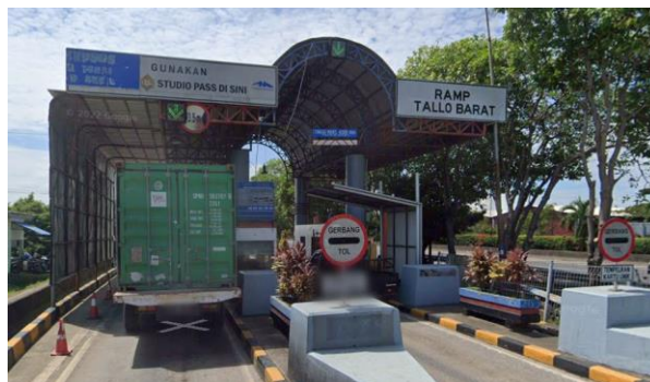
Gambar III.34 Kondisi Eksisting Gerbang Tol Tallo Barat
