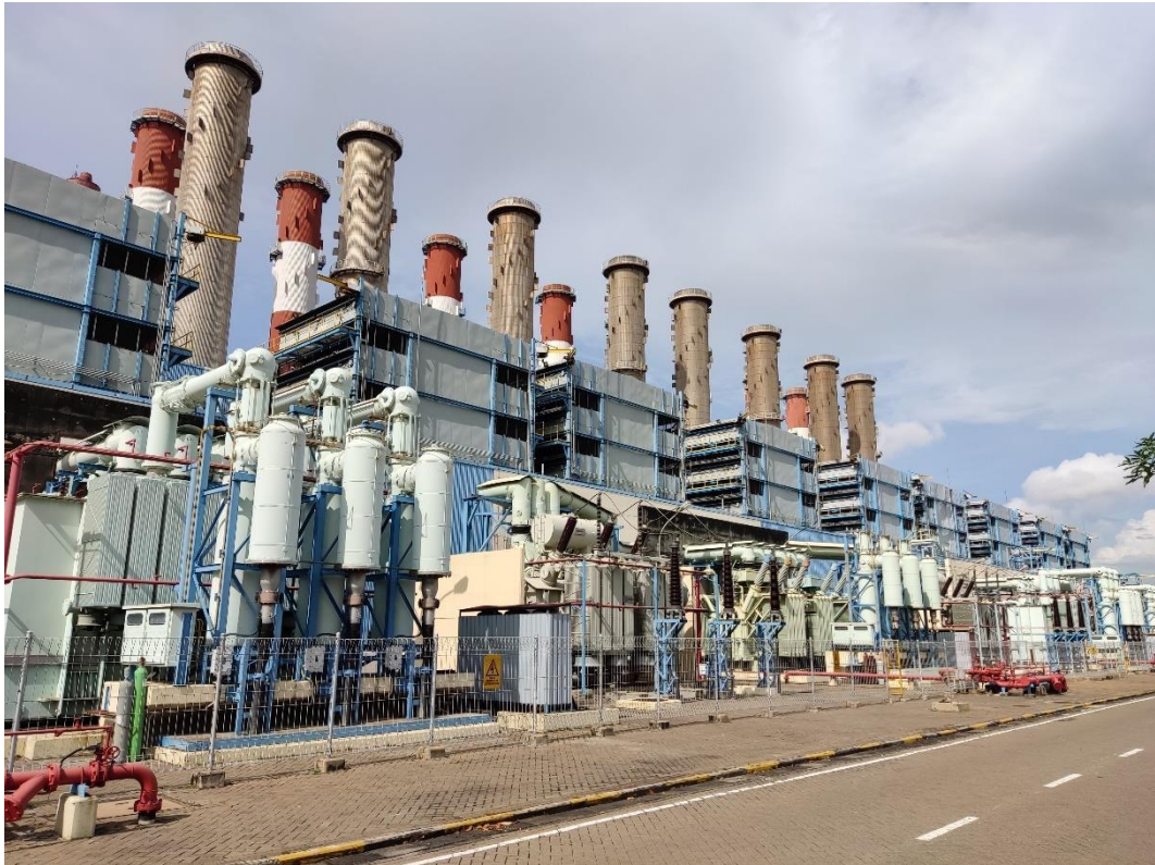
Tampak Belakang Area PLTGU
