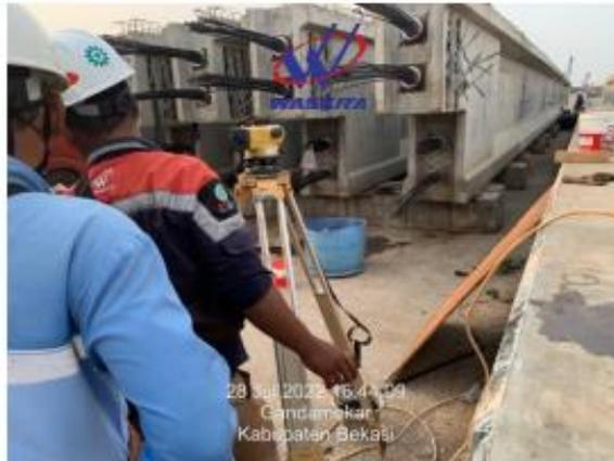
**Gambar 2.19** Survei Lateral dan Vertikal
