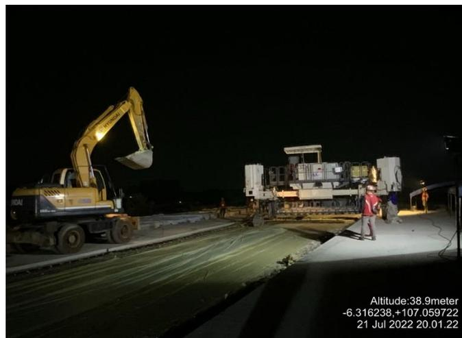
**Gambar 3.15** Pekerjaan *Setting String Line dan Paver*
