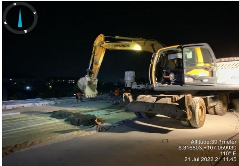
**Gambar 3.29** Proses Penuangan Beton pada Dowel Menggunakan *Excavator*
