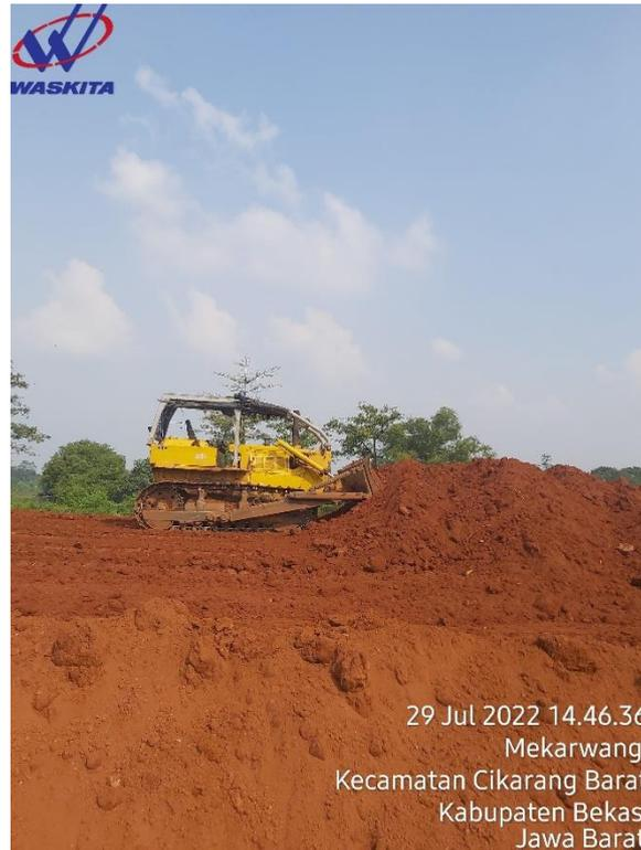
**Gambar 3.11** Pekerjaan Timbunan dan Perataan Tanah
