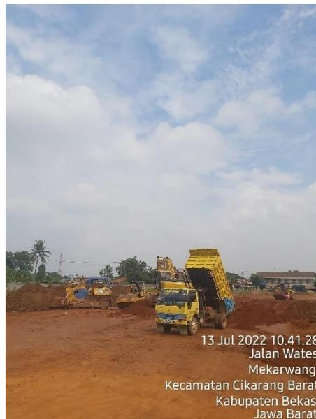
**Gambar 4.15** Proses Pematatan Tanah
