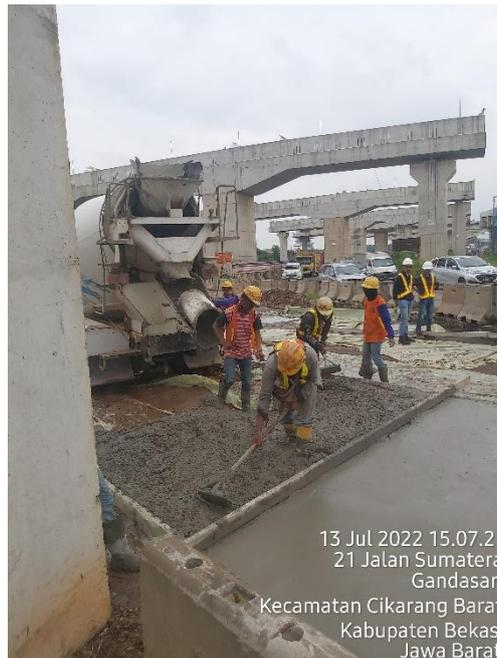
**Gambar 4.1** Pekerjaan Pengecoran Lean Concrete
