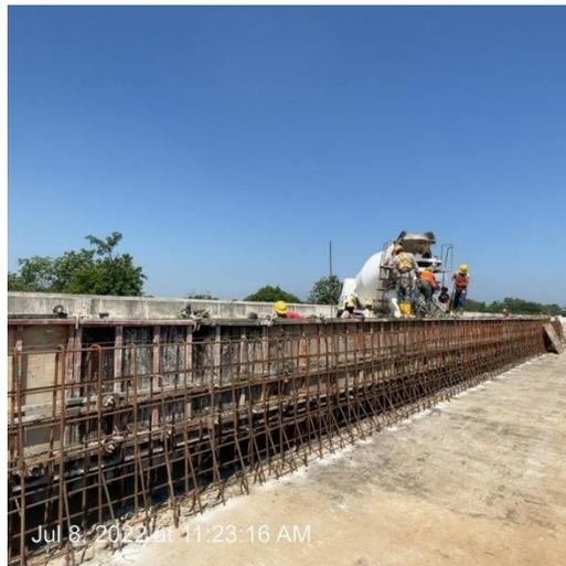
**Gambar 4.19** Proses Pengecoran Median Jalan Tol
