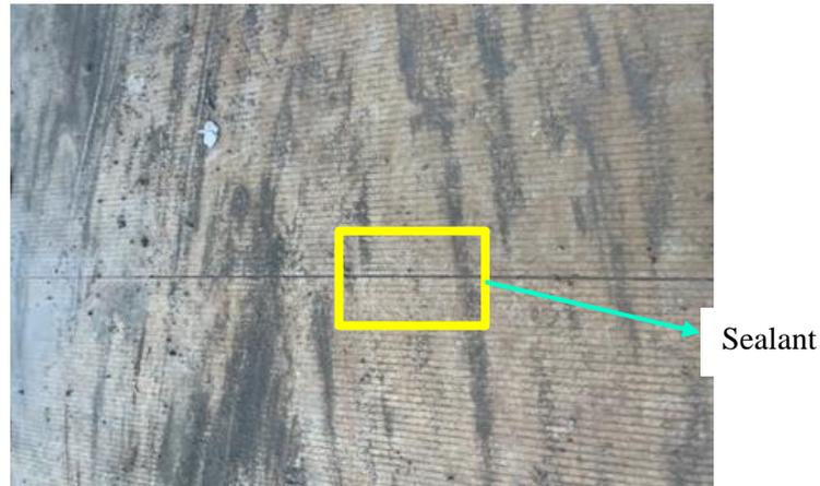
**Gambar 3.24** Pekerjaan *Cutting* Beton dan *Sealant*
