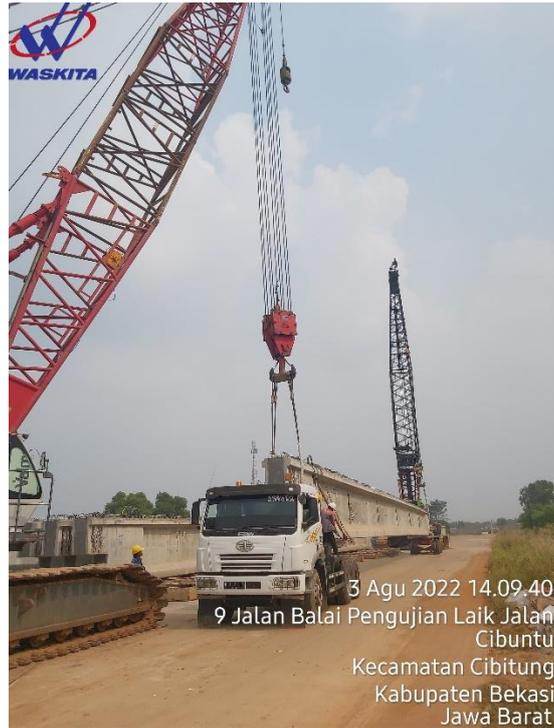
**Gambar 2.23** *Load Test dan Moving Girder Ke Boogie*
