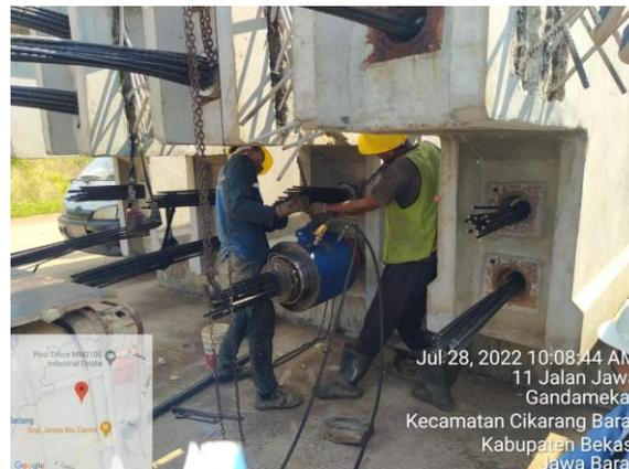
**Gambar 2.17** Instalasi *Jack* dan *Stressing* Hingga *Strand* Tegak Lurus dengan Permukaan *Girder* (*Balanced*)
