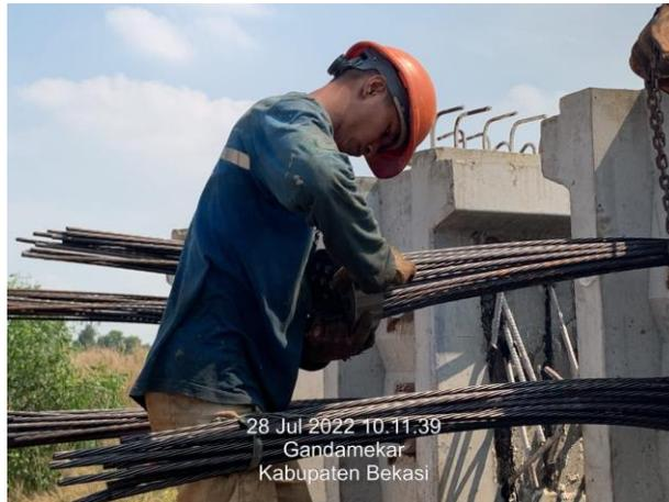
**Gambar 2.14** Pemasangan Angkur Blok dan *Wedges*
