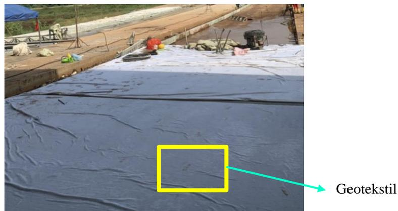
**Gambar 3.23** Pekerjaan *Curing*
