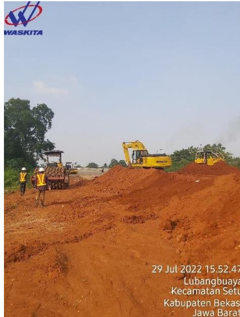
**Gambar 4.16** Proses Pekerjaan Timbunan dan Pemasatan Tanah
