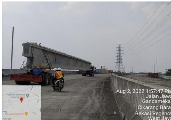
**Gambar 2.24** *Moving Girder Ke Lokasi Feeding*
