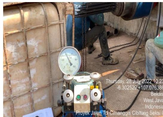
**Gambar 2.18** *Stressing* Secara Bertahap dan Pengukuran Elongasi
