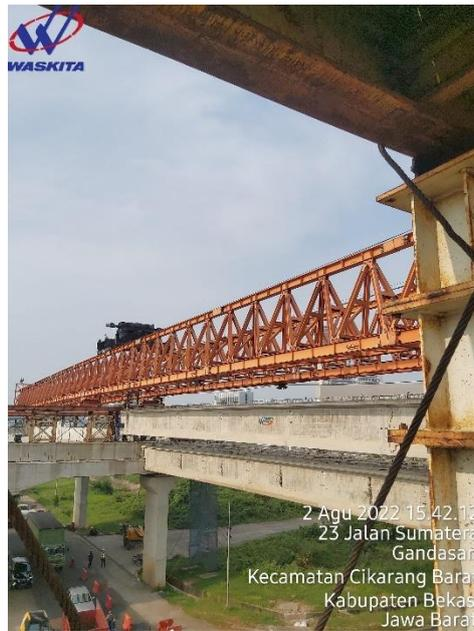
**Gambar 4.13** Proses *Launching* dan *Sliding Girder*
