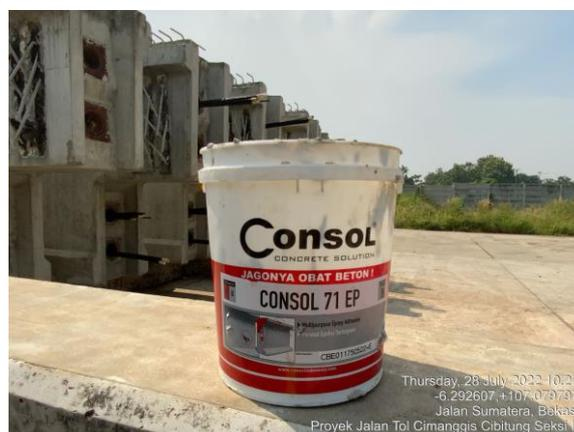
**Gambar 2.16** Pelapisan Consol 71 EP di Setiap Segmen Girder
