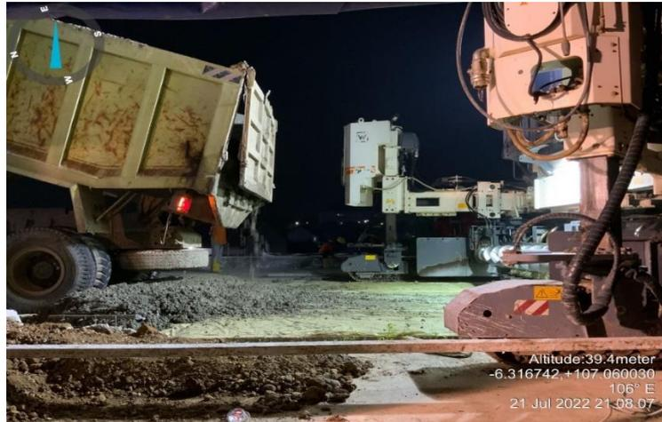
**Gambar 3.28** Proses Penuangan Beton dengan Tinggi Maksimal 0,9 – 1,5 meter
