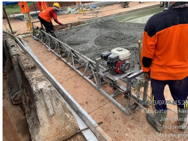
**Gambar 4.4** Proses Perataan Beton Menggunakan *Truss Screeder*
