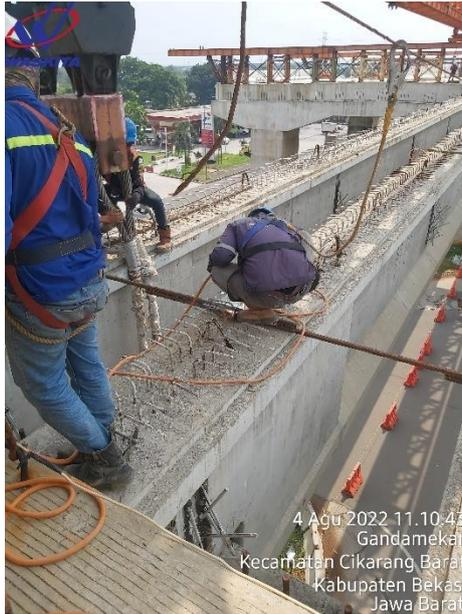
**Gambar 4.14** Proses Pemasangan *Bracing* dan Pengelasan
