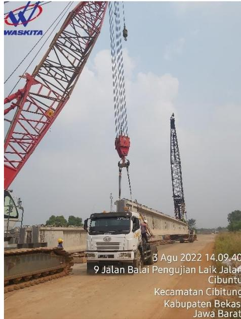
**Gambar 4.10** *Load Test dan Moving Girder ke Boogie*
