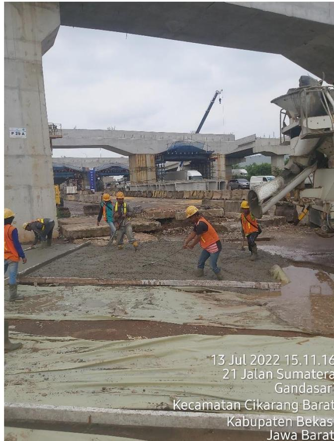
**Gambar 3.13** Pekerjaan Pengecoran *Lean Concrete*
