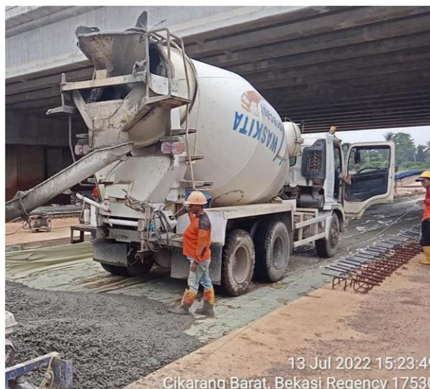
**Gambar 4.2** Pekerjaan Pengecoran Beton Kelas E (K125)
