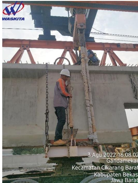
**Gambar 2.25** Pemosisian Sling Angkat pada *Handling Point*
