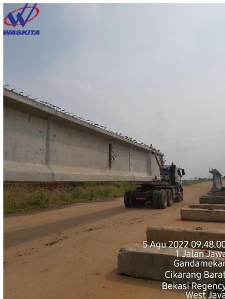
**Gambar 4.11** *Boogie Bergerak dari Stockyard ke Launcher Gantry*
