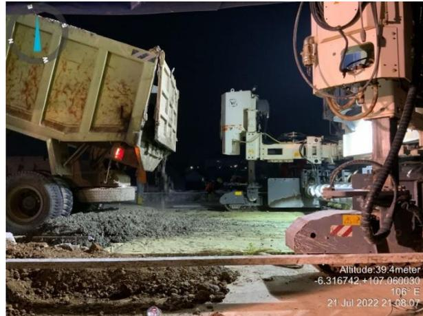
**Gambar 3.16** Pekerjaan Penuangan Beton
