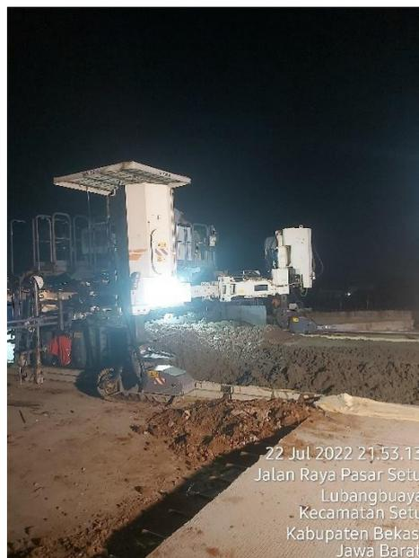
**Gambar 4.7** Perataan Beton Kelas P Menggunakan Alat *Wirtgen*
