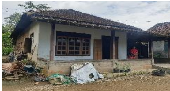
Gambar 3.13 Kondisi Awal Rumah Bapak Darat
