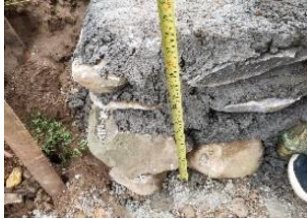
Gambar 3.6 Tampak Pondasi Batu Kali Rumah Bapak Sarip
