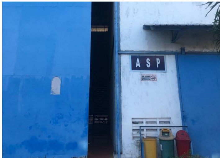
Kegiatan operator dan monitoring aliran gas pada ASP Plant
