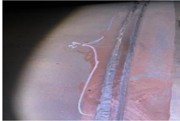
Gambar 4.30 Temuan Crack pada Exhaust manifold
