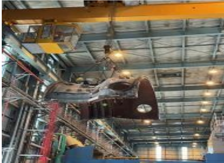
Gambar 4.28 Proses pengangkatan upper casing turbin
