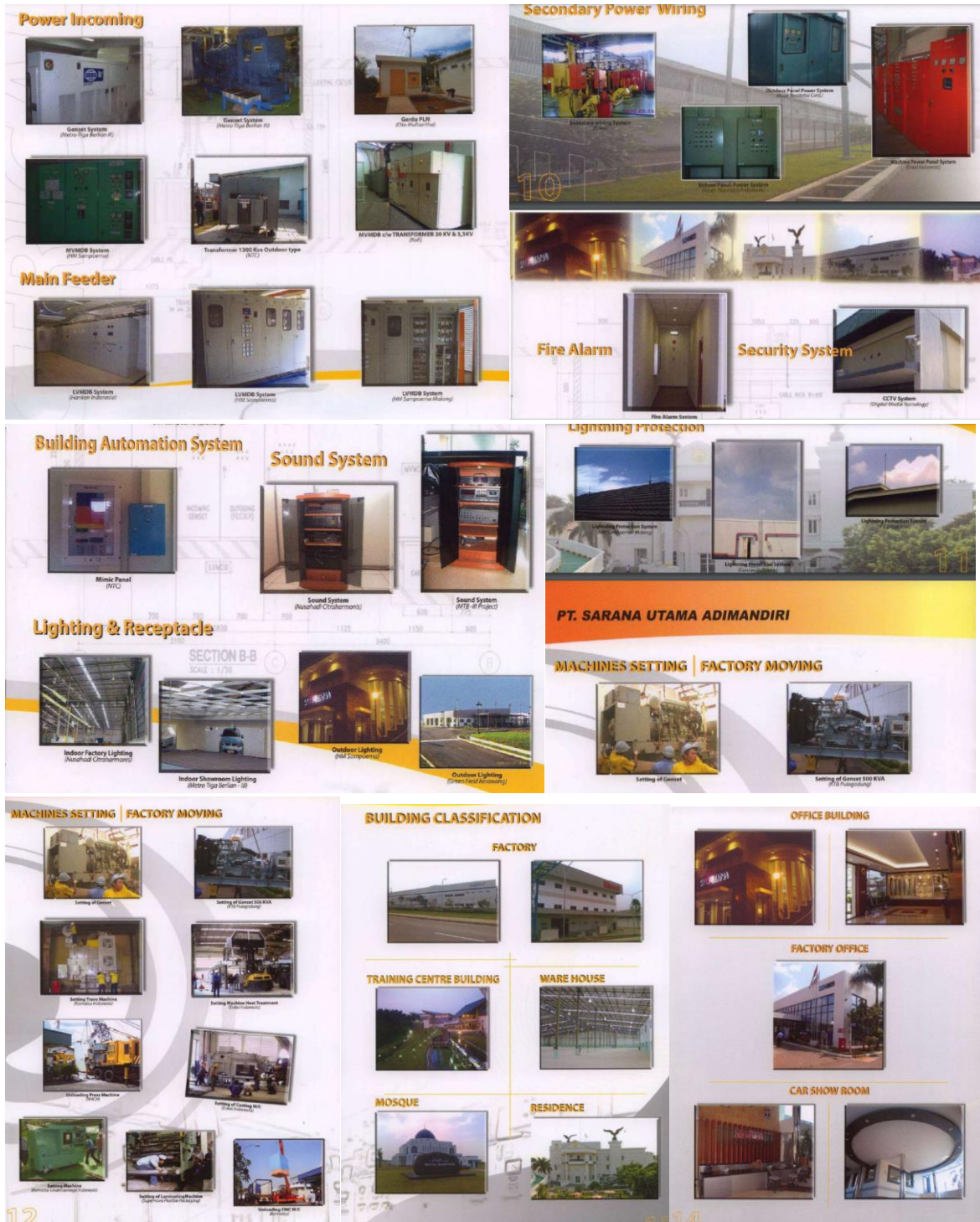
Gambar 2.4 Electrical Working PT Sarana Utama Adimandiri
