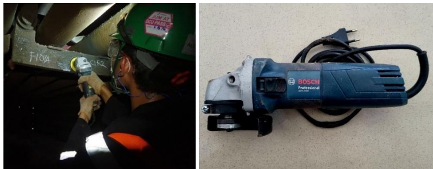
Gambar 4.20 pembersihan terak menggunakan gerinda
