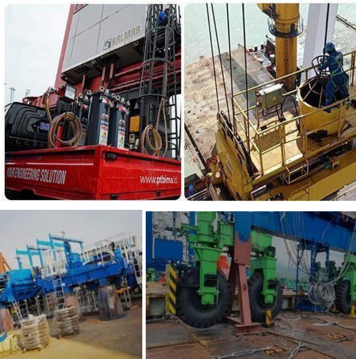
Gambar 2.18 Kegiatan layanan peralatan pelabuhan bidang mekanikal elektrik
