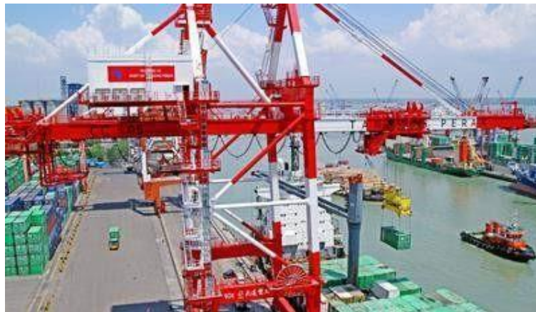
Gambar 4.19 Container Crane 05 di Terminal Nilam
