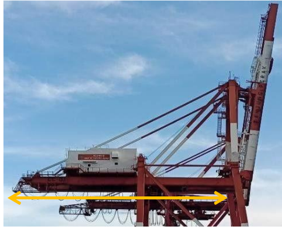
Gambar 4.27 Girder pada CC 05
