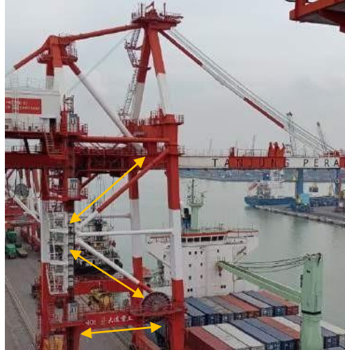
Gambar 4.32 Cross Beam dan Portal Beam pada CC 05 (Sumber : Dokumentasi Pribadi)
