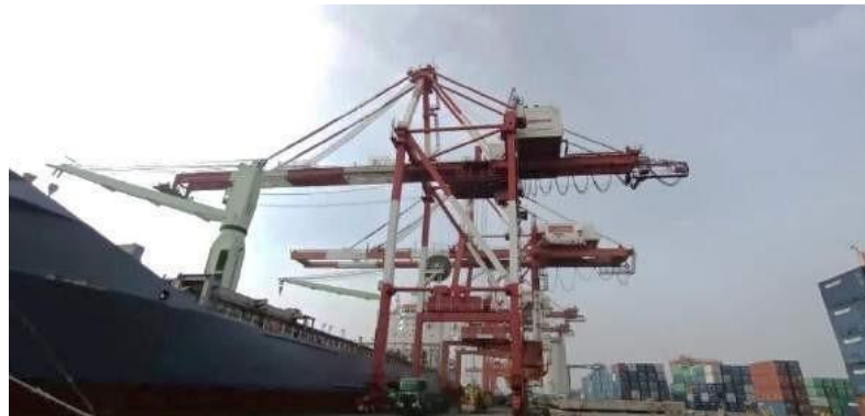
Gambar 2.8 Container Crane 03 di Terminal Nilam
