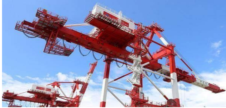
Gambar 4.18 Container Crane 04 di Terminal Nilam
