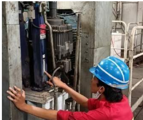
e) Adjustment sensor endstop pada trolley RTG
