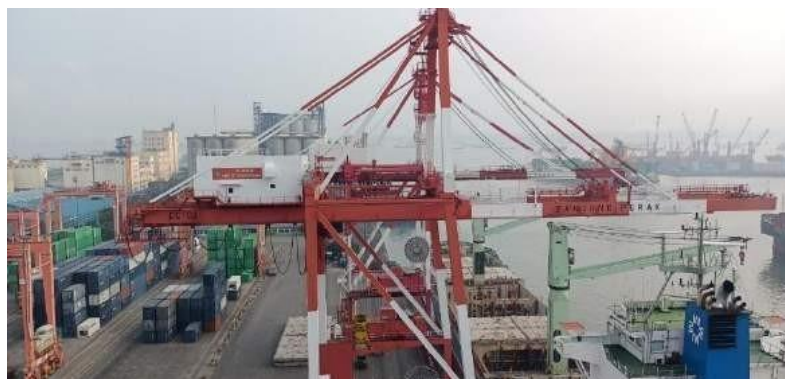
Gambar 4.15 Container Crane 01 di Terminal Nilam (Sumber : Dokumen Pribadi)
