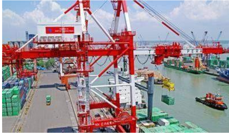
Gambar 2.10 Container Crane 05 di Terminal Nilam
