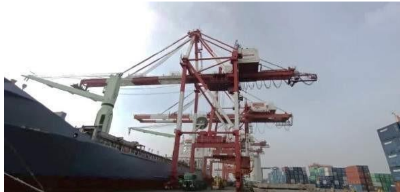
Gambar 4.16 Container Crane 03 di Terminal Nilam
