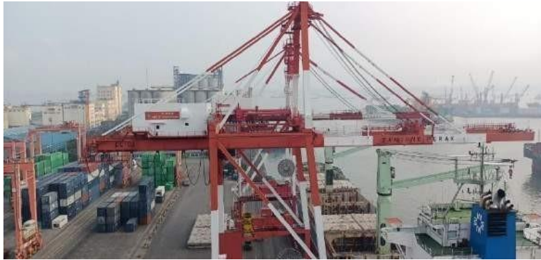
Gambar 2.7 Container Crane 01 di Terminal Nilam
