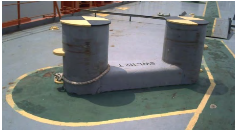
Gambar 4.63 Foto existing Konstruksi Bolder pada FSO Ladinda
