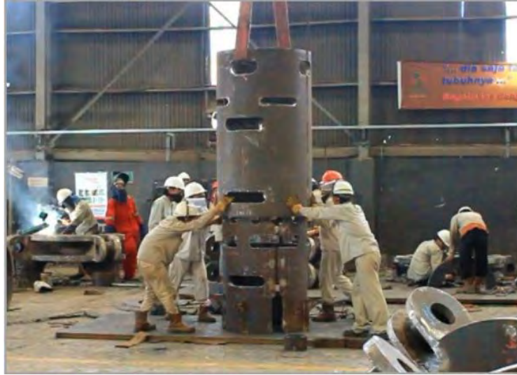
Gambar 1.3 Proses Fabrikasi Clamp (Extension Deck Leg)
