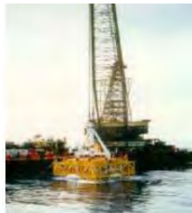
a) Konvensional - menggunakan Crane Barge
