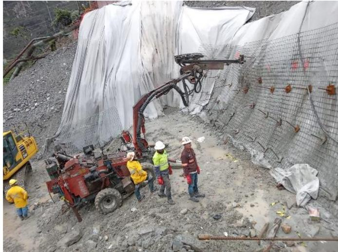
**Gambar 5. 3** Inspeksi Pekerjaan *Soil Nailing* Gravity Feed Box
