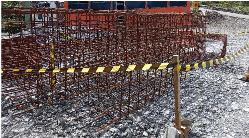
**Gambar 2. 27** Tulangan Dari Pondasi *Guard rail*
