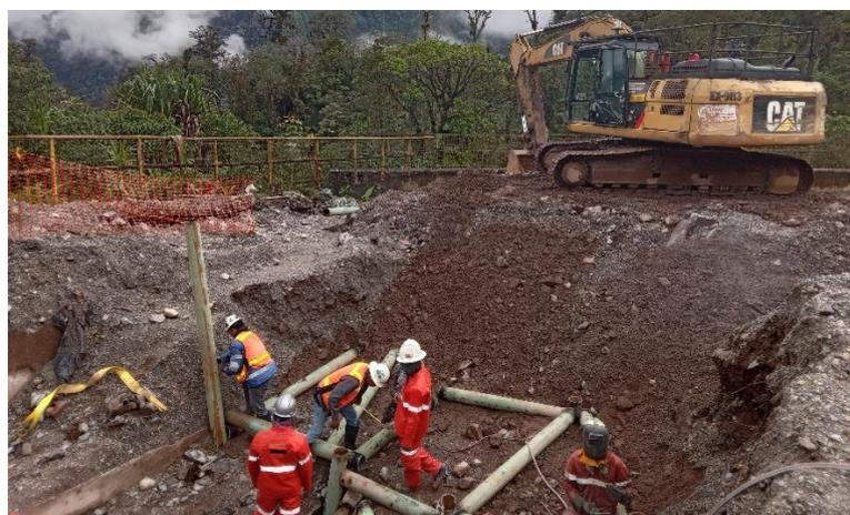
**Gambar 3. 14** Pemancangan Menggunakan Material Pipa Konsentrat
