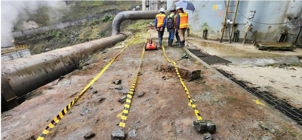
**Gambar 5. 1** *GPR Test* di Area *Mill*
