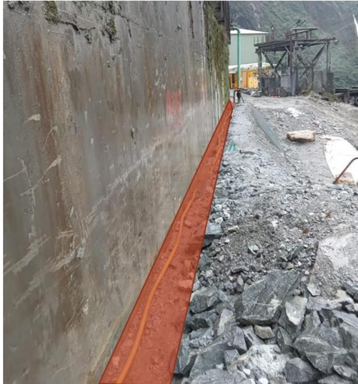
**Gambar 4. 8** Rencana Posisi Drainase Untuk mengalihkan Aliran Air
