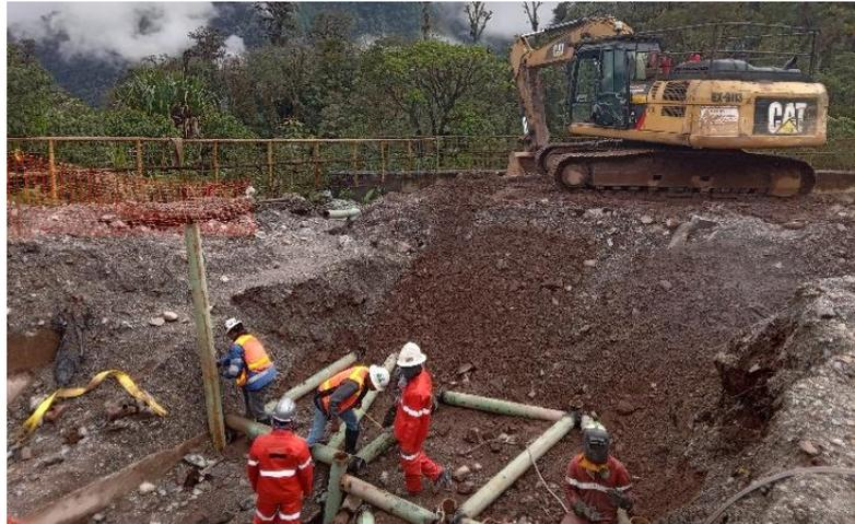
**Gambar 2. 28** Proses Pemasangan Micropiles Untuk RTH
