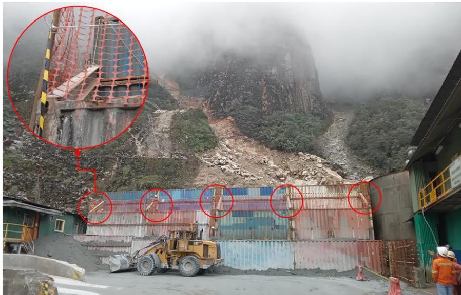
**Gambar 4. 16** *Container barrier* yang dilengkapi *bracing*
