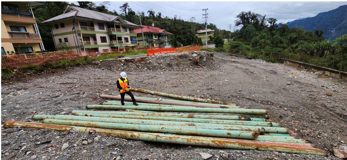
**Gambar 5. 9** Material Bekas Pipa Konsentrat yang Digunakan Sebagai *Micropiles*
