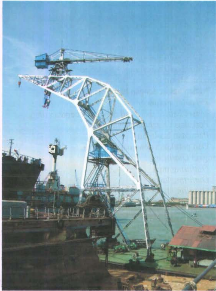
Gambar 3.5. Floating crane PT.Dok dan Perkapalan Surabaya (PT.Dok dan Perkapalan Surabaya, 2007).
