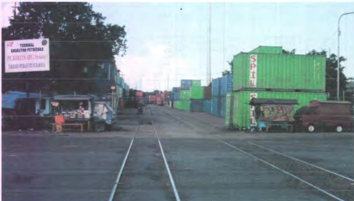
Gambar 4.23. Terminal Angkutan Kereta Api Peti kemas Prapat Kurung, Tanjung Perak
