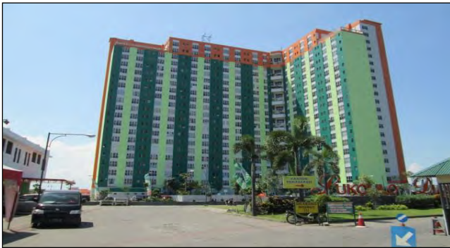
Gambar 5.5-1 Kondisi gedung secara keseluruhan
