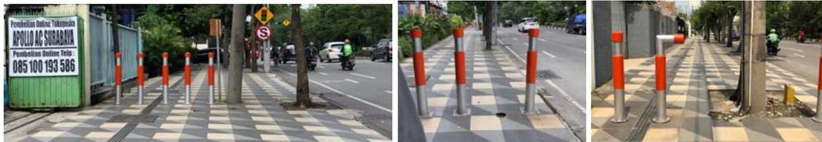
**Gambar 4. 17 Peletakan Bollard dengan jarak yang tidak konsisten pada Segmen H (kiri), Segmen F (tengah), dan Segmen I (kanan)**
