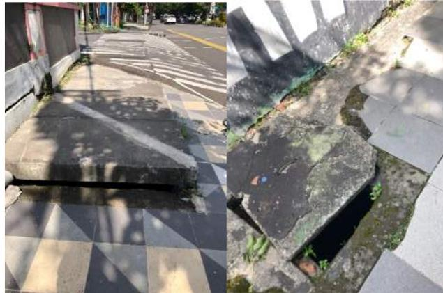
**Gambar 4. 34 Tutup drainase yang belum dalam kondisi baik pada Segmen C (kiri) dan Segmen D (kanan)**
