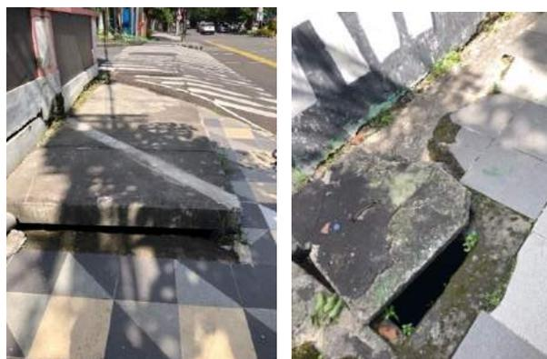
**Gambar 4. 38 Tutup drainase yang belum dalam kondisi baik pada Segmen C (kiri) dan Segmen D (kanan)**
