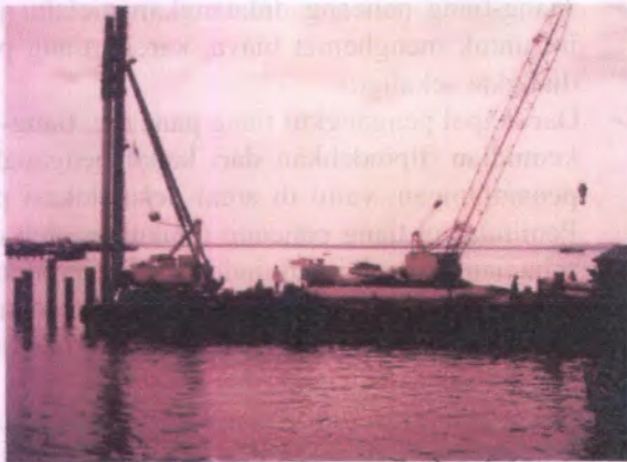
Gambar 7.1 – Ponton pancang dan ponton crane
