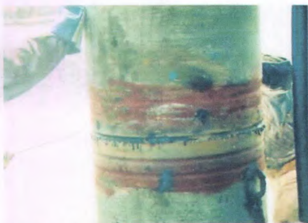
Gambar 7.5 – Penyambungan tiang pancang
