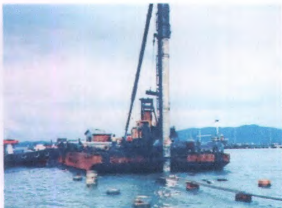
Gambar 7.4 – Pemancangan tiang pancang
