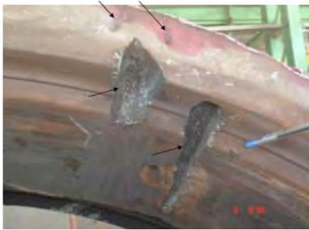
Gambar 2.10 Retakan pada Roller Tyre
