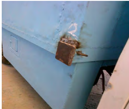
Gambar 1.2 Celah yang terjadi karena ketidaksesuaian posisi peletakan box
