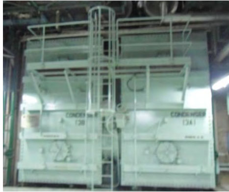
Gambar 2.3 Kondensor PLTU unit 4
