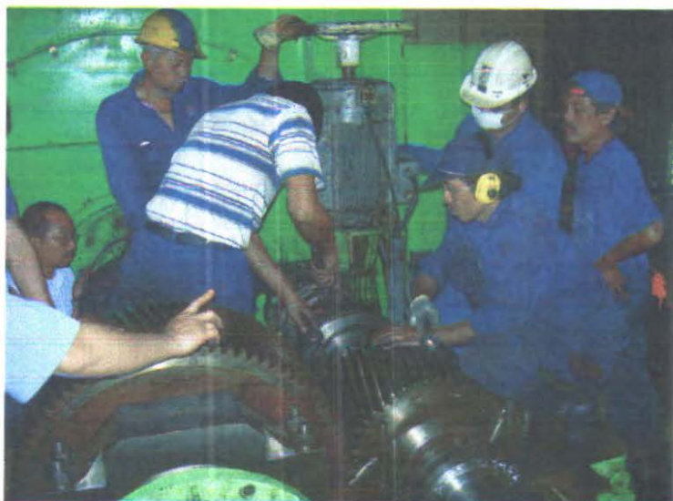
Gambar Pemasangan Komponen Gear Box setelah Over Houl
