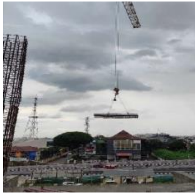
Gambar 5.7 Pengangkatan Tulangan dengan Tower Crane
