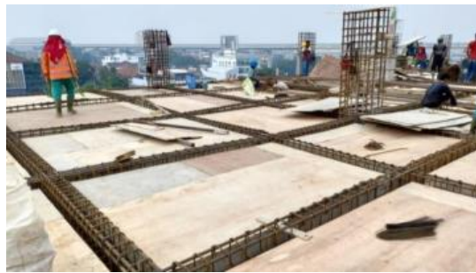
Gambar 5.9 Pekerjaan Pemasangan Bekisting Balok dan Pelat
