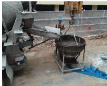
Gambar 5.14 Pengecoran Tangga dengan Conceret Bucket
