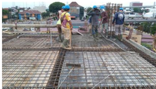
Gambar 5.11 Pengecoran Balok dan Pelat Lantai
