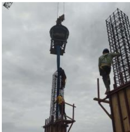
Gambar 5.4 Pengecoran Kolom dengan Concrete Bucket
