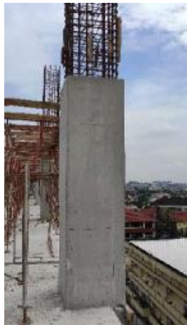
Gambar 5.5 Hasil Pembongkaran Bekisting pada Kolom
