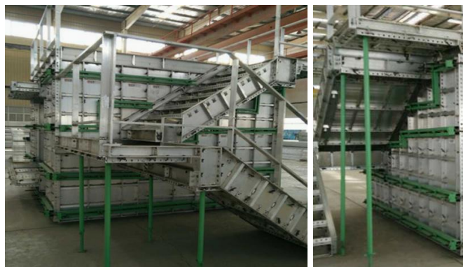
Gambar 5.15 Bekisting Aluminium Pada Tangga (Sumber: BossGoo)
