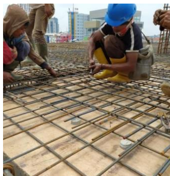
Gambar 5.8 Pemasangan Tulangan Pada Pelat Lantai
