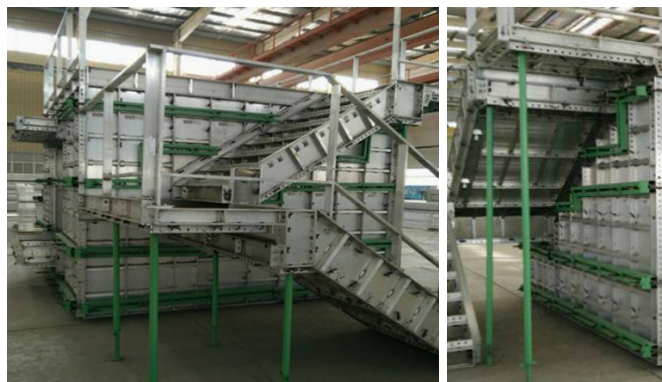
Gambar 5.15 Bekisting Aluminium Pada Tangga (Sumber: BossGoo)
