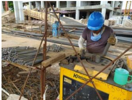
Gambar 5.6 Pekerjaan Memotong Tulangan dengan Bar Cutter
