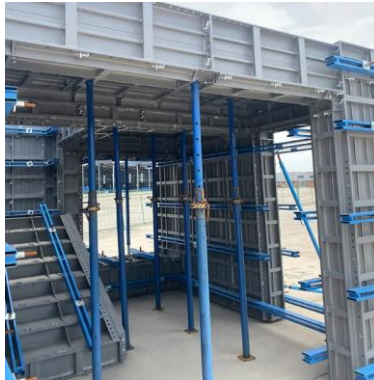
Gambar 5.12 Bekisting Aluminium Pada Balok dan Pelat (Sumber: Sampax)
