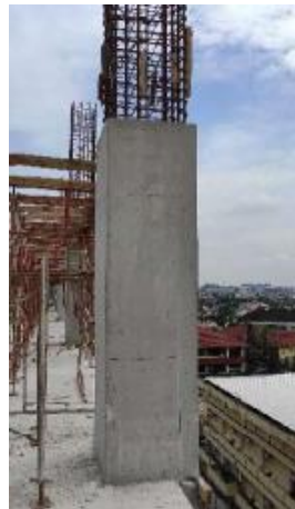
Gambar 5.5 Hasil Pembongkaran Bekisting pada Kolom
