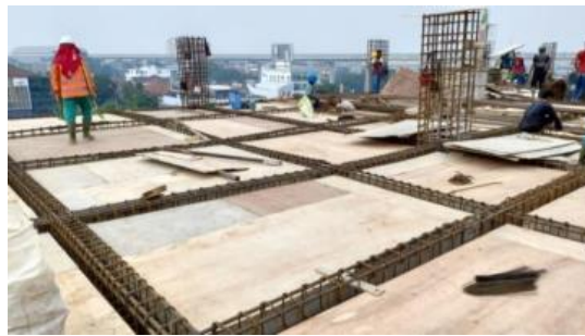
Gambar 5.9 Pekerjaan Pemasangan Bekisting Balok dan Pelat
