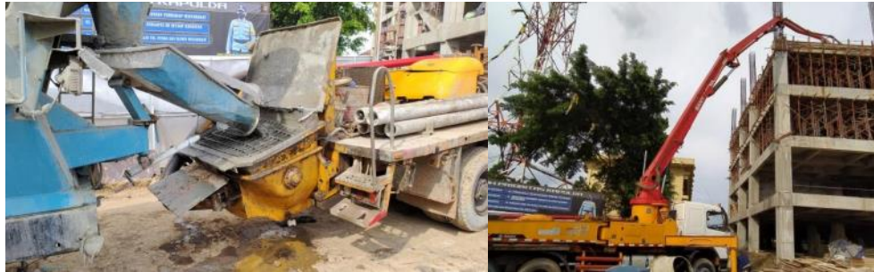
Gambar 5.10 Penuangan dan Pengaliran Beton dari Concrete Mixer ke Concrete Pump
