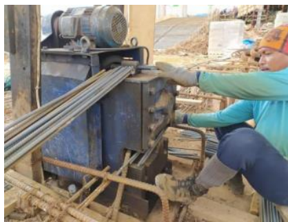
Gambar 5.1 Pekerjaan Memotong Tulangan dengan Bar Cutter
