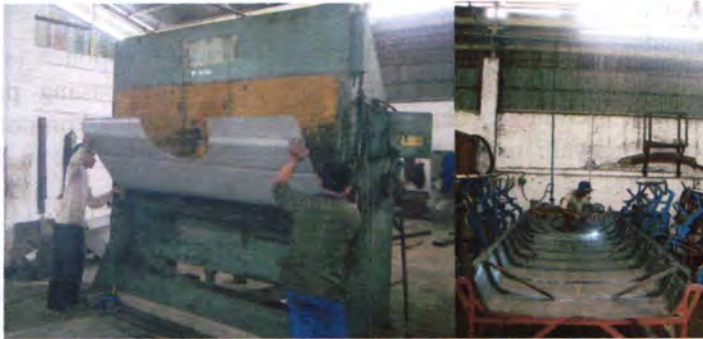
Gambar 2.5. Proses bending pada komponen sub-assy mobil yang berupa plat (kiri), proses pembuatan komponen sub-assy berbentuk roof (kanan).
