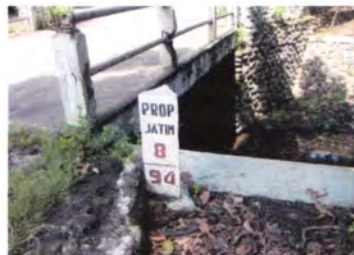
kondisi drainase jalan pada STA 94+800
