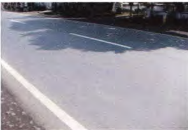
Kondisi existing jalan pada STA 96+300
