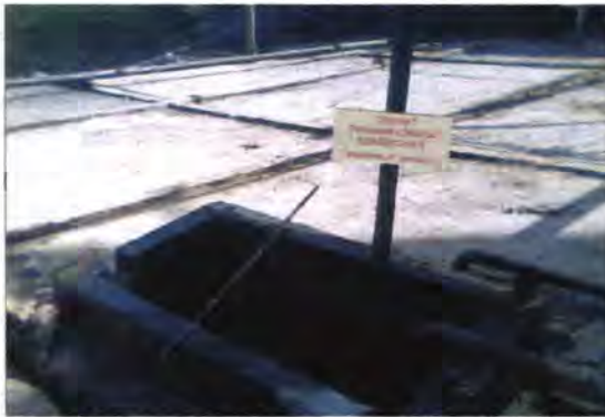
Gambar 2.5 Bak Penampung Phenolic Water (Sumber: Dokumen Pribadi PT XYZ)
