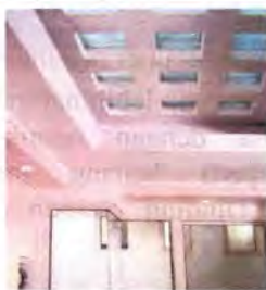
Gambar 2.28. Plafon Glassblock yang menempel pada dak beton
