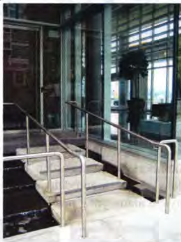
Gbr 4.22 Tangga beton cetak
