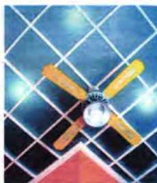
Gambar 2.29. Plafon fiber pada interior, semi transparan dan tidak terlalu silau
