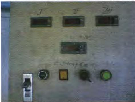
Gambar 4.23 Indikator temperatur untuk ruang muat
