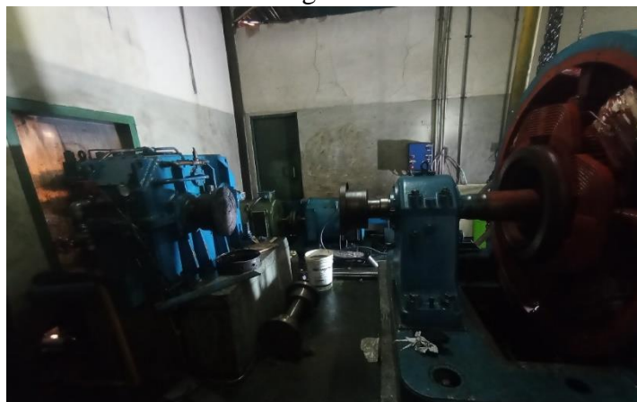
Gambar 4. 23 Proses Pemasangan Motor 360 HP (Sumber: Dokumentasi Pribadi 2024)
