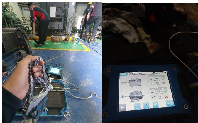
Gambar 4. 21 Penyiapan Alat Alignment Shaft (Sumber: Dokumentasi Pribadi 2024)
