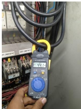
Gambar 5.25 Pengukuran Beban Menggunakan Amperemeter (Sumber: Dokumentasi Pribadi 2024)
