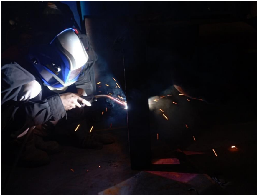
Gambar 5.18 Proses Pengelasan (Sumber: Dokumentasi Pribadi 2024)
