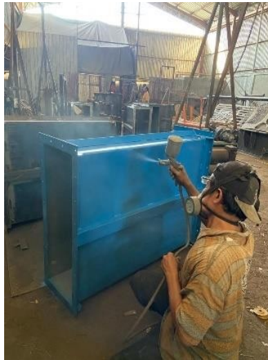
Gambar 5.13 Proses Finishing (Pengecatan) Casing Bucket Elevator (Sumber : Dokumentasi Pribadi)
