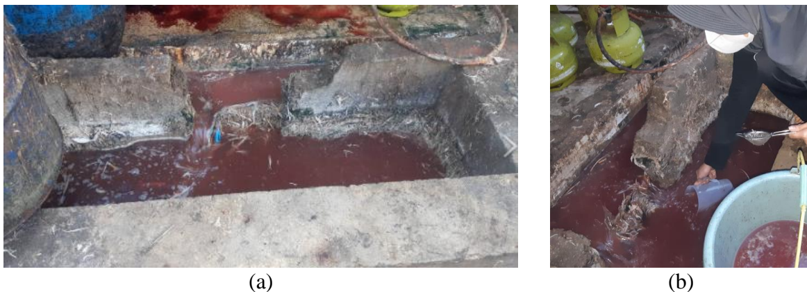
Gambar 4.1 (a) Bak Pengumpul Limbah Cair RPA dan (b) Pengambilan Limbah Cair RPA
