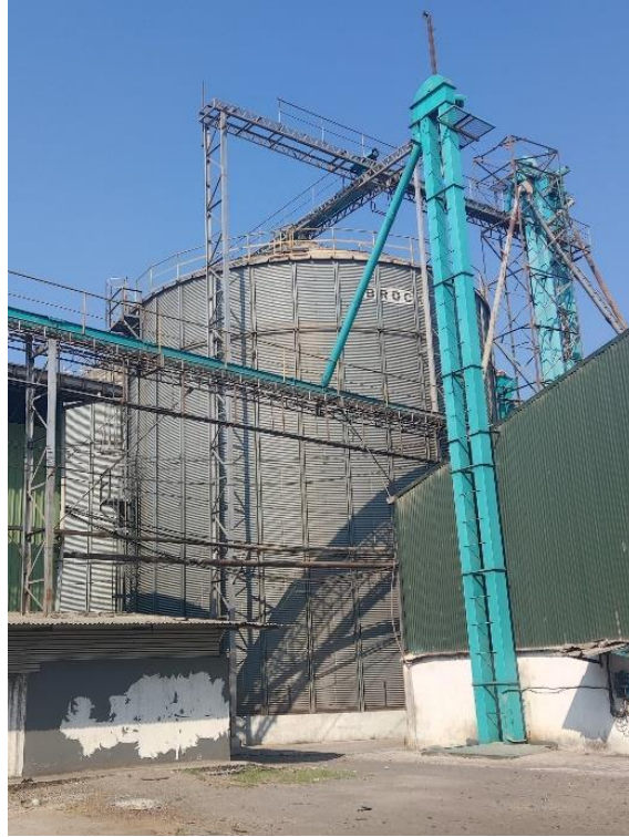
Gambar 4. 3 Silo untuk Penyimpanan Bahan Baku Produksi Pakan Ternak
