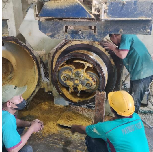
Gambar 4. 11 Pembongkaran Pellet Mill untuk Penggantian Ring Die dan Roller yang Aus
