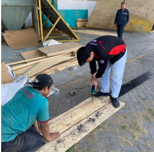
Gambar 4. 18 Pengeboran Belt untuk Pemasangan Bucket
