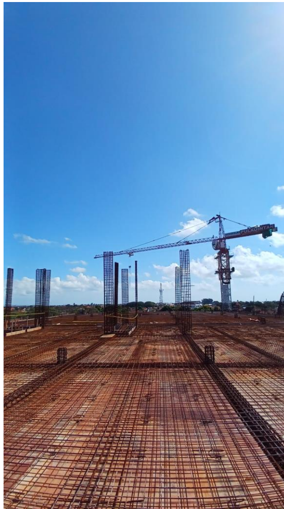
Gambar 4.1 Pengerjaan Lantai 4 Magnum Residence Sanur Pada Bulan Mei 2024
