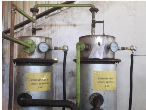
**Gambar 3.26** Pemasangan *Instrument* pada Tangki Pemanas Nira
