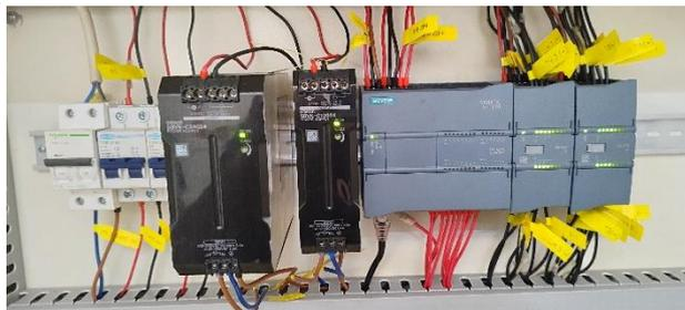
**Gambar 3.24** Instalasi PLC pada *Panel Box* Kontroler
