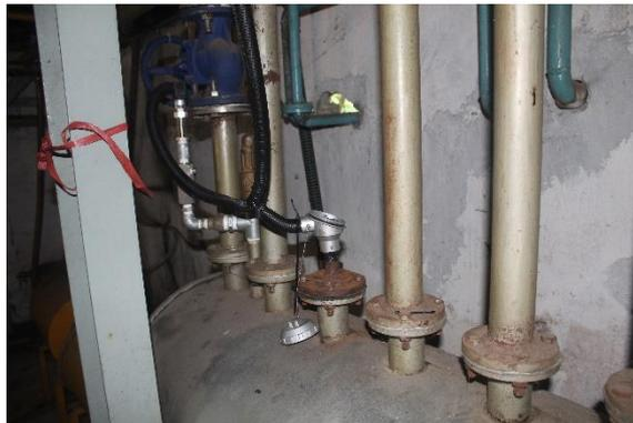
**Gambar 3.25** Pemasangan *Instrument* pada Tangki *Header Kettle*
