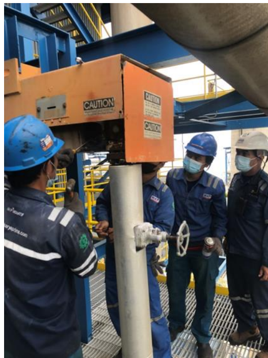
Penggantian seal pada sootblower IK
