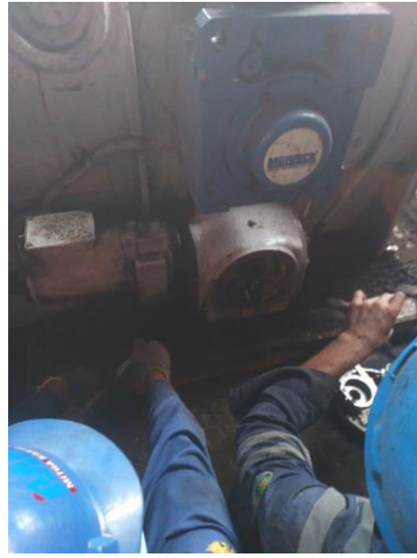
Pengecekan Pulley Motor pada coal feeder
