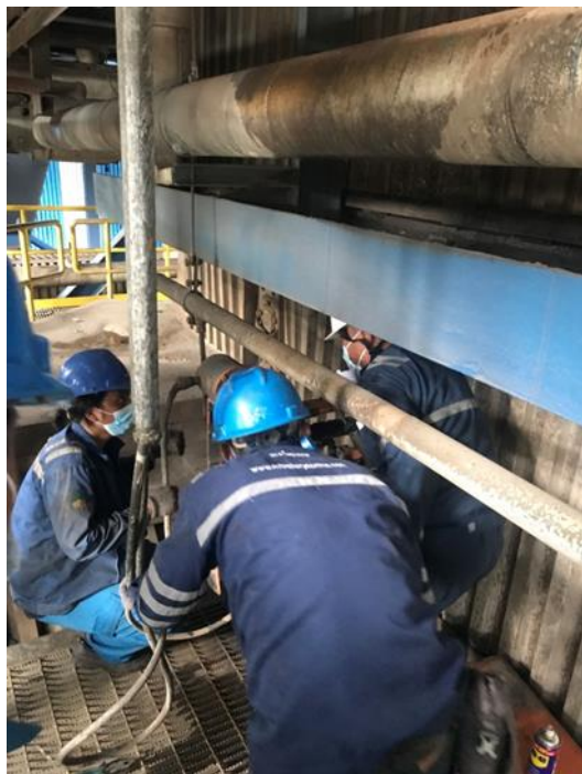
Perbaikan pen kopling pada sootblower IR
