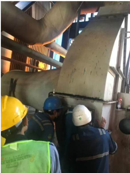
Pengecekan impeller pada Mill Seal Air Fan
