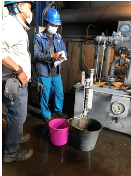
Penggantian filter pada gearbox pulvulizer
