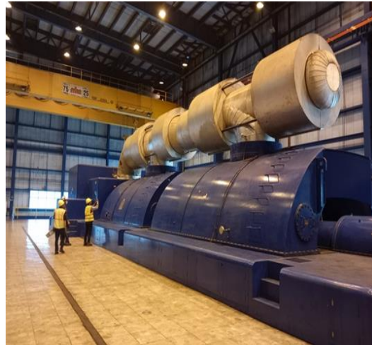
Pengecekan kebersihan area turbin
