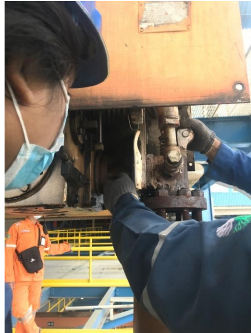
Corrective maintenance pada sootblower IK perbaikan pada poppet valve
