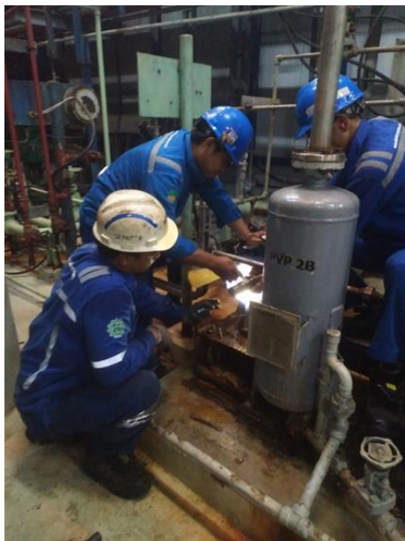
Pengelasan pada kebocoran pipa alat PVP
