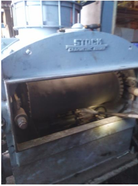
Pelepasan manhole pada alat Coal Feeder untuk internal check
