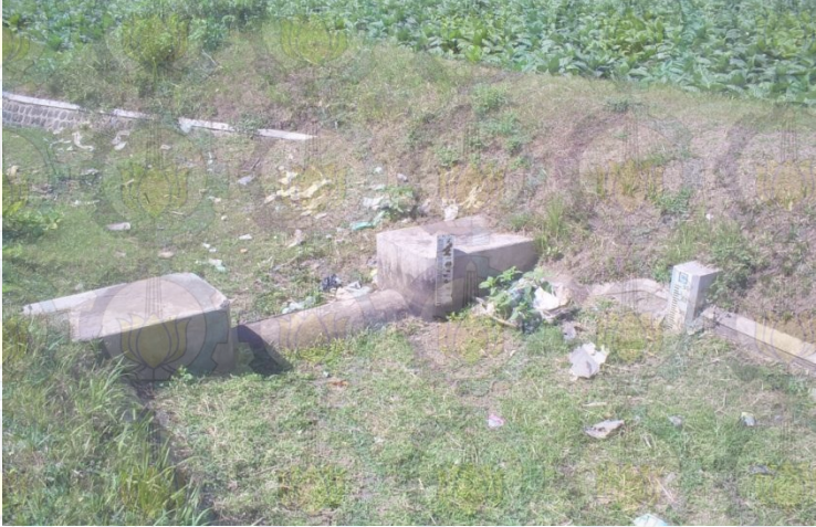
Saluran Sekunder Nogosari ( tidak ada aliran disaluran)
