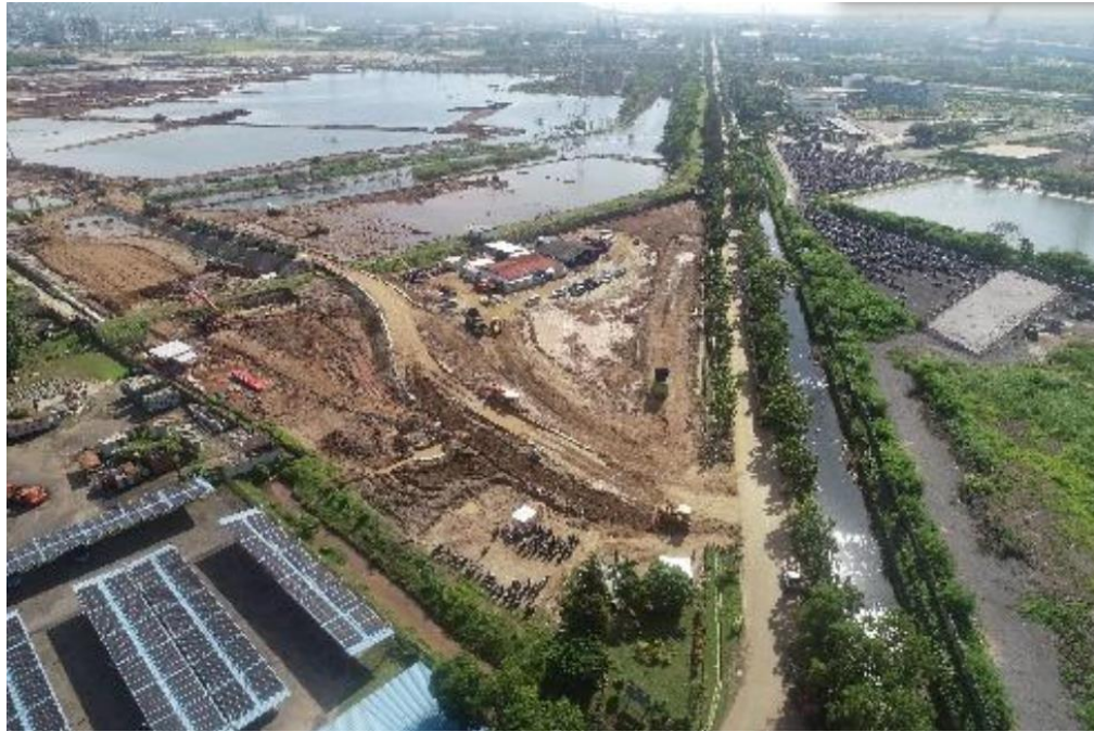
Gambar 1. 2 Kondisi tanah pada land preparation PT Chandra Asri Alkali
