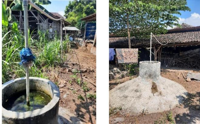
Gambar 4.15 Pipa yang menghubungkan Biodigester ke Dapur-Dapur Rumah Tangga
