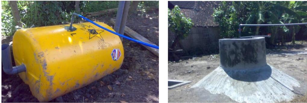
Gambar 4.13 Biodigester dengan *Model Floating Type* dan *Fixed Dome Type*
