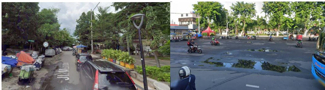
Gambar 4. 6 Kondisi Ruas Jalan sekitar Taman 10 Nopember
