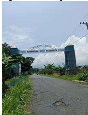
Gambar 4. 54 Kondisi Jalan (Sumber: Survei Primer, 2024)
