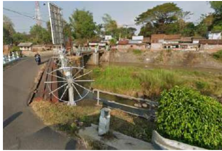
Gambar 4. 80 Bendungan Sungai Kunci Kecamatan Ngetos (Sumber: Google Maps Review, 2023)
