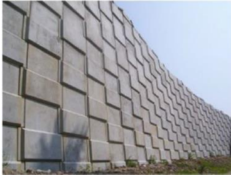
Gambar 2. 9 Ilustrasi Pemasangan GSRW
