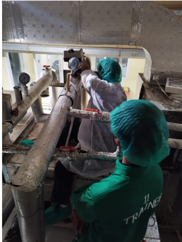
Melakukan pengukuran flow debit aliran air Air Handling Unit (AHU)
