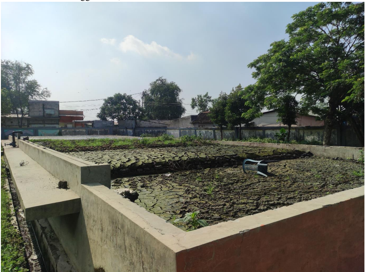
Gambar 2. 8 Tempat Pengeringan Lumpur (SDB)
