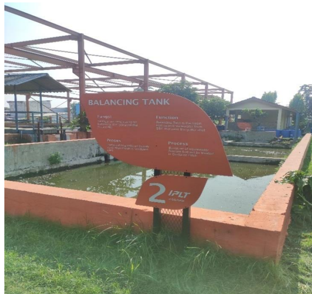
Gambar 2.3 Tanki Penyeimbang (BT)
