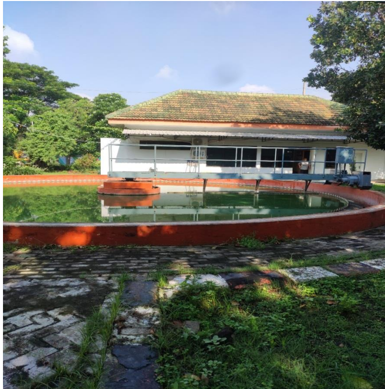
Gambar 2. 6 Alat Pengendap Akhir (Clarifier)
