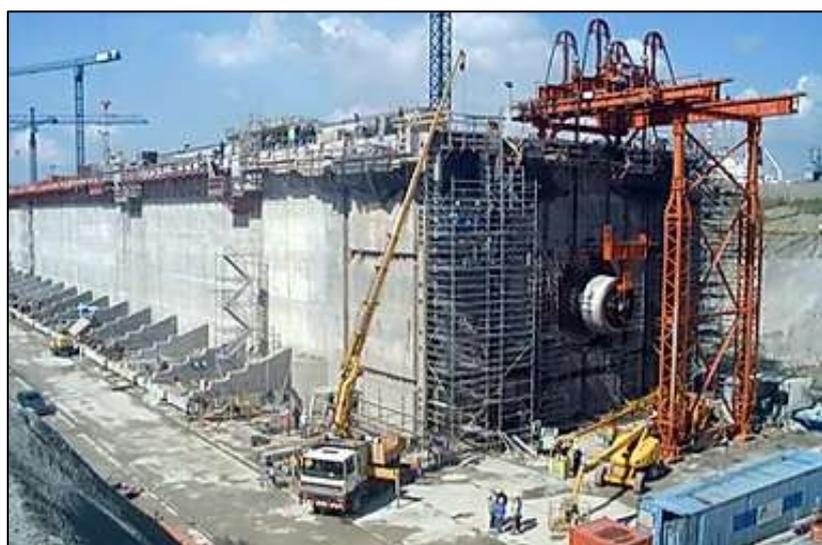
**Gambar 1.4** Konstruksi FB di pelabuhan Monaco [6]
